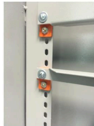
Figura 2: Detalhe da longarina e aplicação dos isoladores
