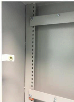
Figura 2: Detalhe da longarina e aplicação dos isoladores
