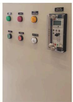
Composto por relé de proteção microprocessado, disjuntor em caixa moldada, transformadores de corrente baixa tensão janela e demais componentes.
